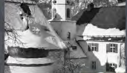
Beckert, August Wallfahrtskirche St.Anton, Garmisch-P...
