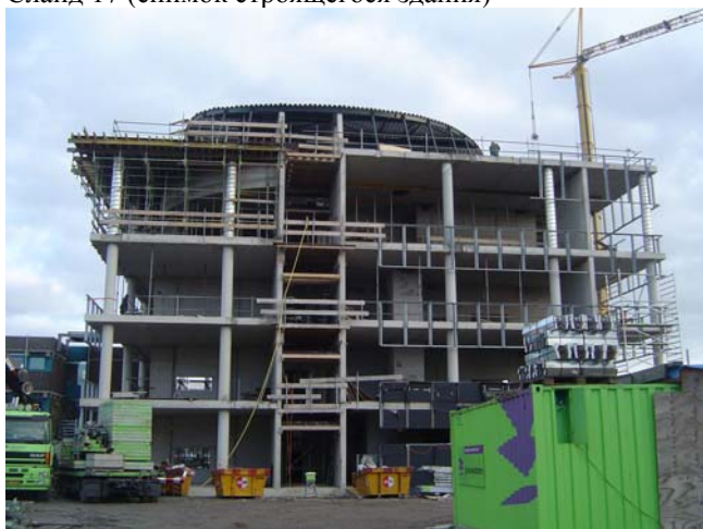
Слайд 17 (снимок строящегося здания)
